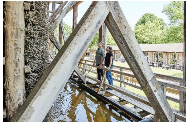
Foto 5: Gradierwerk Bad Orb, Copyright Bad Orb Kur GmbH
