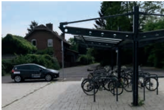
Abbildung 56: Multimodale Abstellanlagen auf dem Bahnhofsvorplatz in Bruchköbel
