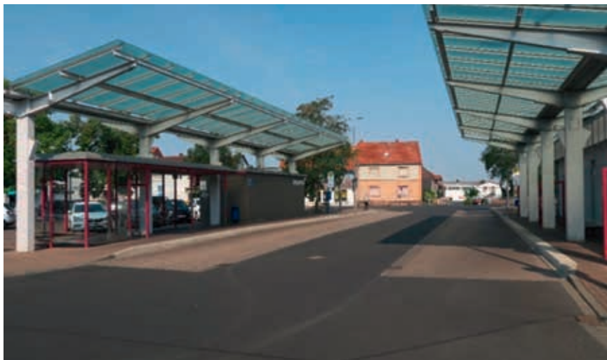
Abbildung 30: Integrierte Umsteigehaltestelle im Zentrum von Somborn
