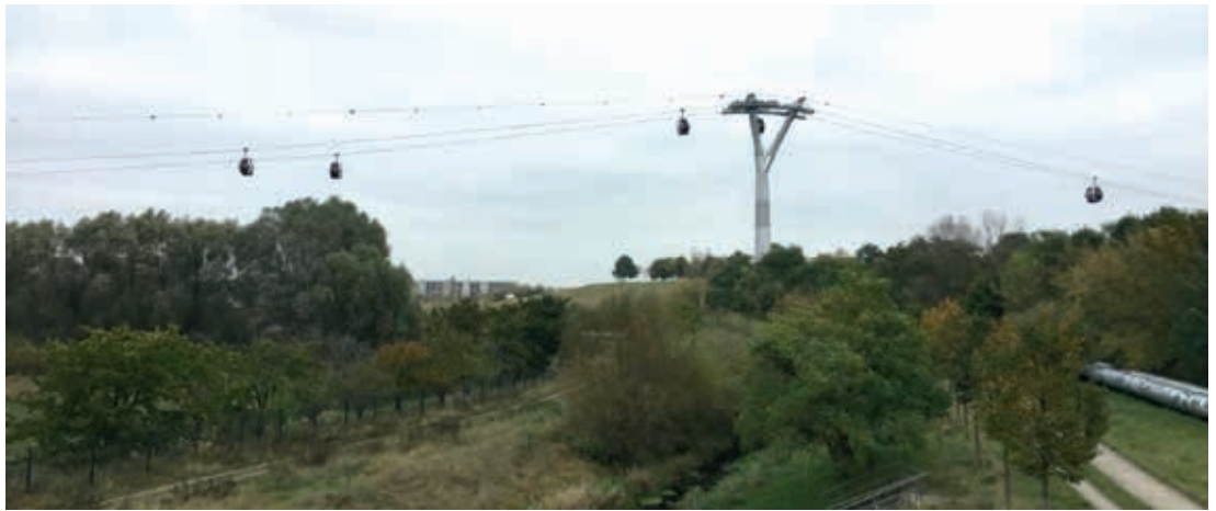
Seilbahn Berlin Hellersdorf
