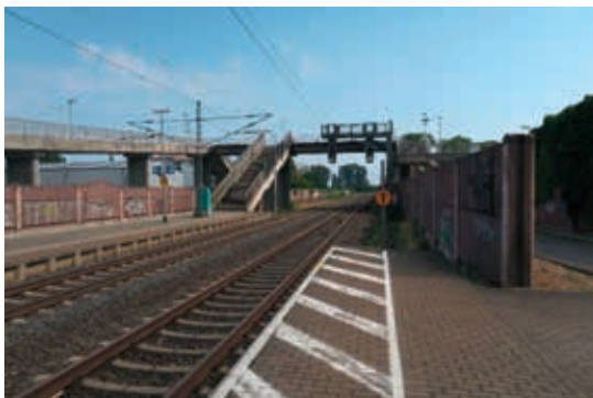
Abbildung 18: Rodenbach Bhf am Lärmschutz
