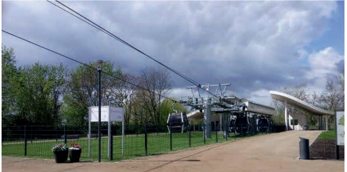
Seilbahn Berlin Hellersdorf, Zwischenstation »Kienberg«
